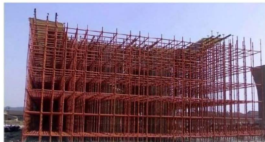
图 3.3.3-4 满堂架支撑
