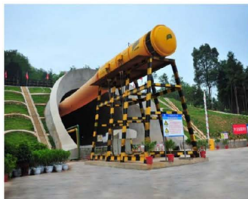
图 3.4.1-1 隧道口通风机架设示意图
