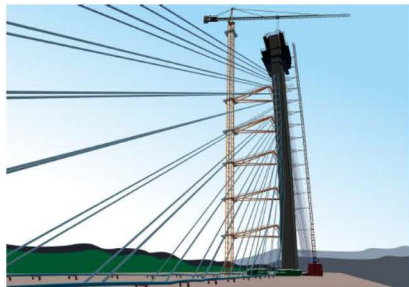
图 3.3.3-10 斜拉桥拉索施工
