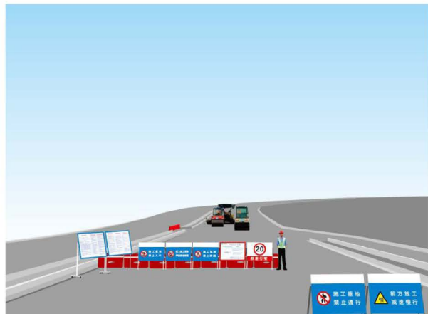
图 3.2.4-1 沥青路面施工防护
