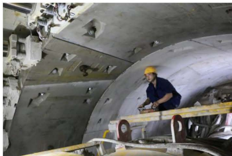
图 3.5.2-2 管片拼装
